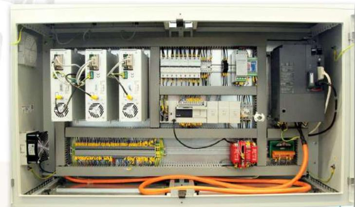
Vista interior del cabinete donde se instalaron tres generadores SE - BOX 2000 Watt - 20 kHz
